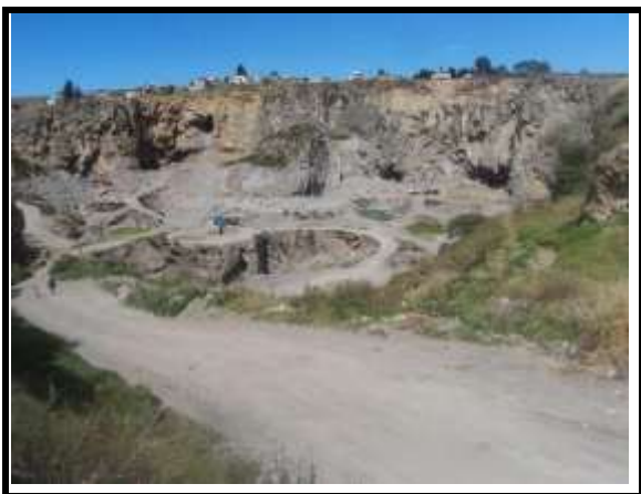
Fotografía 5: Banco o mina de piedra, Jicaltepec Autopan, municipio de Toluca, Estado de México.
